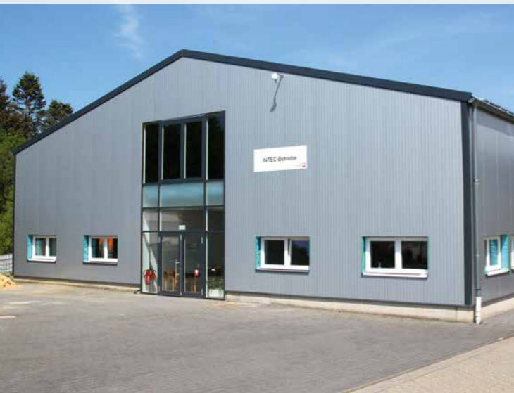
Außenansicht der neuen INTEC-Betriebe in der Nikolaus-August-Otto-Straße
