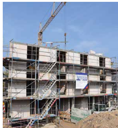
Der Bau schreitet zügig voran.
