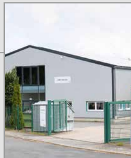
Blick auf das umgebaute Gebäude in der Nikolaus-August-Otto-Straße
