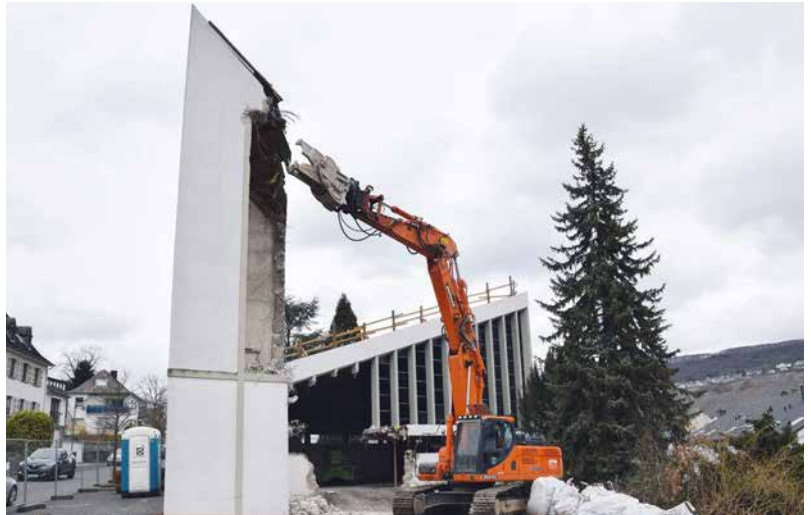
Abriss der profanierten Marienkirche: Am 28. März wurde der Glockenturm abgetragen.
