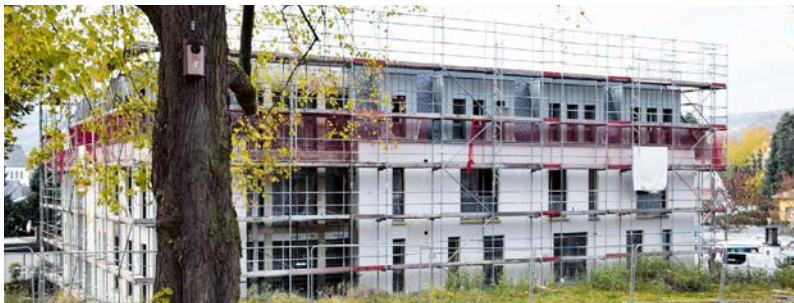
Der Bau in der Koblenzer Straße 52 in Mayen schreitet voran.
