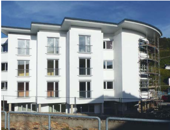
Blick auf den neuen Anbau, in dem auch der Caritasverband Mosel-Eifel-Hunsrück Büros nutzen wird.
