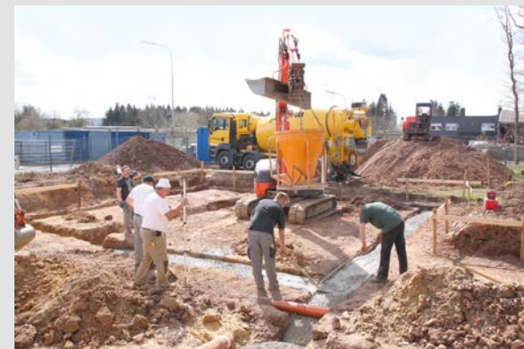
Vorsicht, Baustelle! Hier entsteht der Anbau des Speisesaals.
