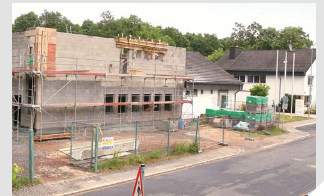
Die Bauarbeiten schreiten gut voran...
