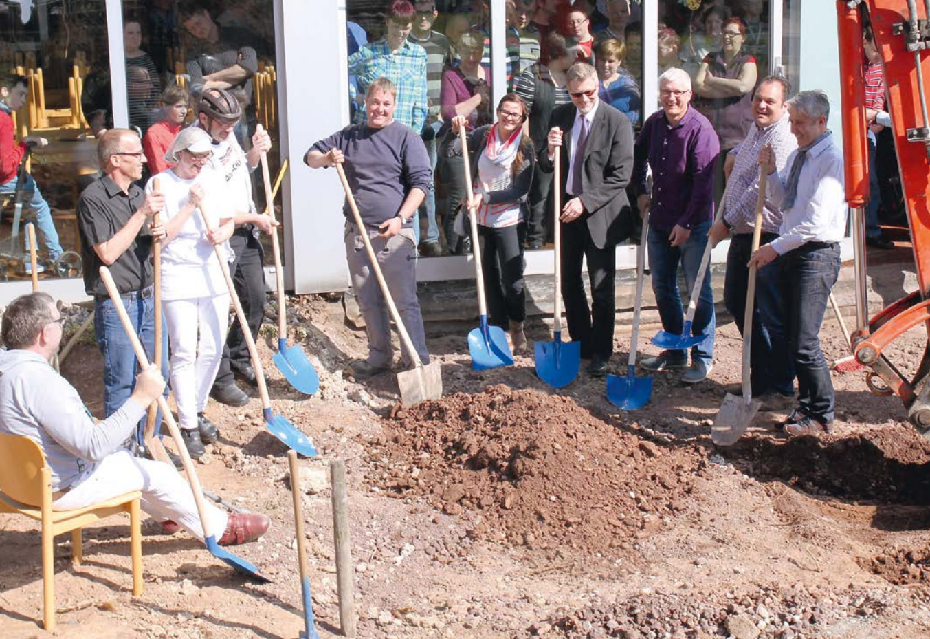
Los geht's: Baubeginn am 29. März 2017 in den Caritas Werkstätten im Industriegebiet Cochem-Brauheck
