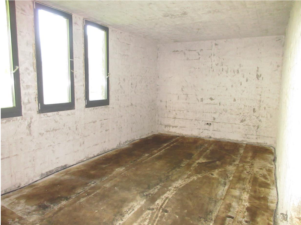
Caritas Werkstätten Sinzig: TAF-Gruppenraum im Zustand April 2022
