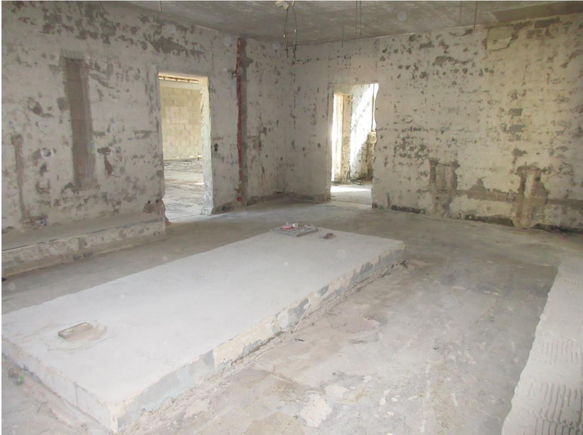
Caritas Werkstätten Sinzig: Großküche im Zustand April 2022
