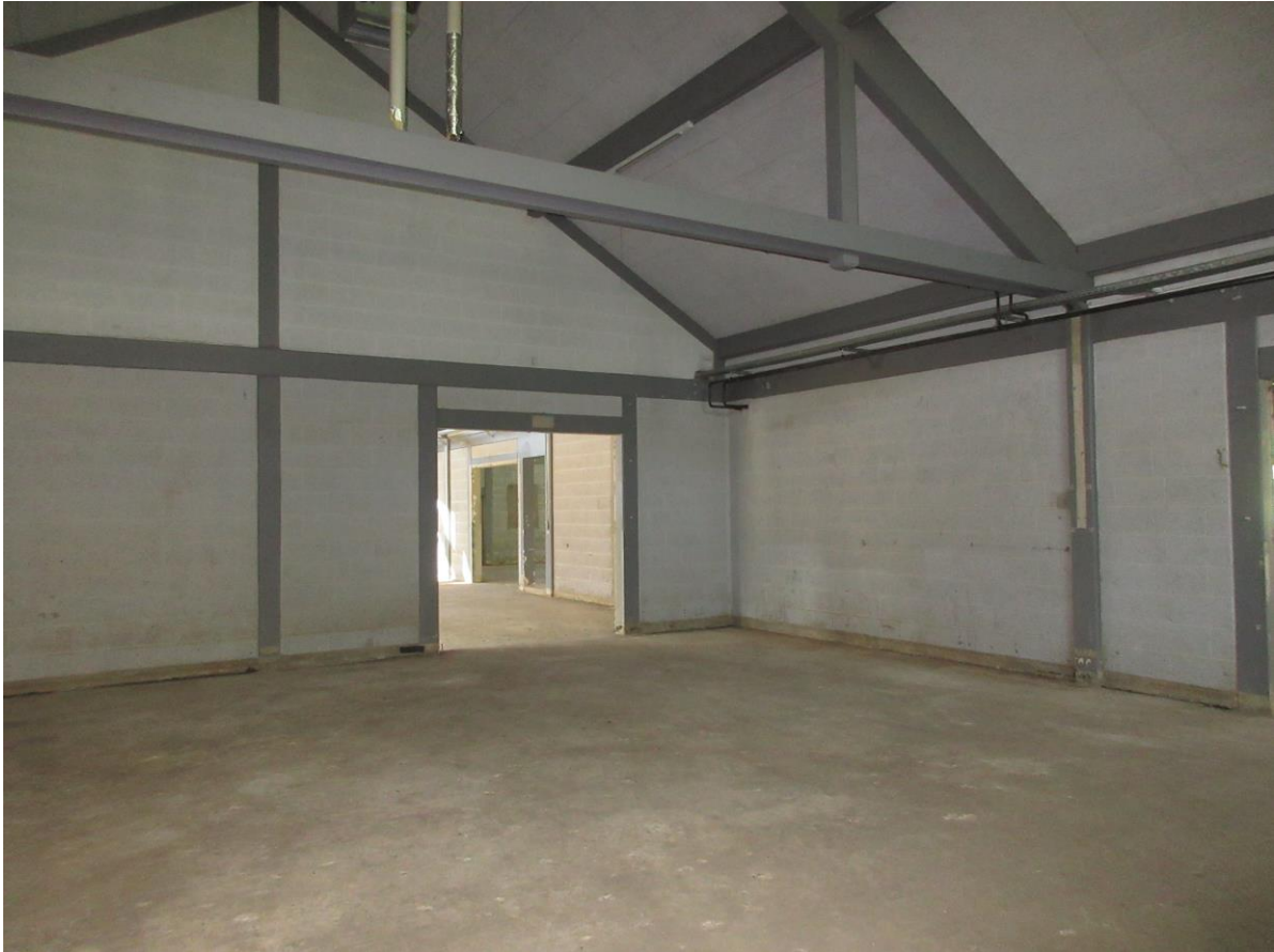
Caritas Werkstätten Sinzig: Lager im Zustand April 2022
