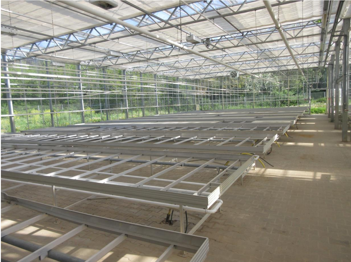
Caritas Werkstätten Sinzig: Gewächshaus im Zustand April 2022
