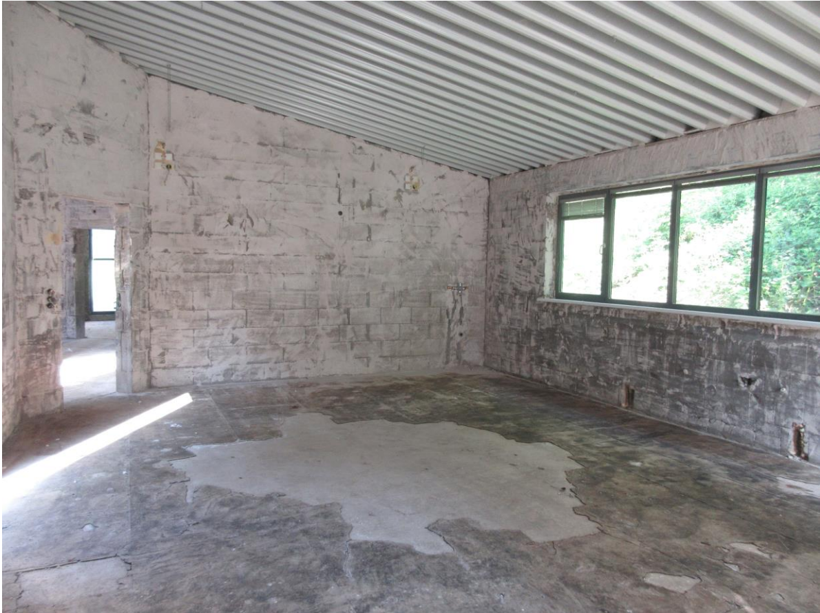
Caritas Werkstätten Sinzig: Räumlichkeiten der Fördergruppe im Zustand April 2022
