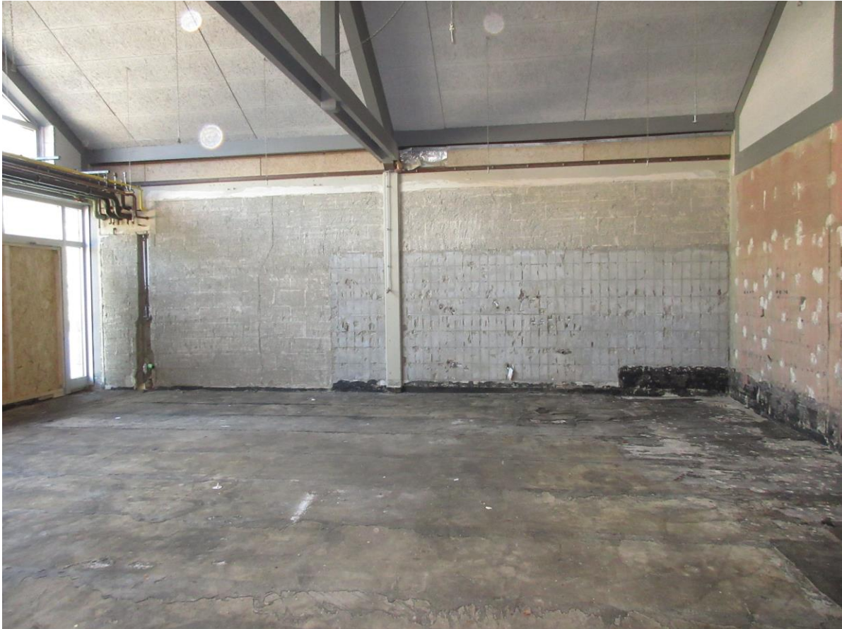
Caritas Werkstätten Sinzig: Räumlichkeiten der Haustechnik im Zustand April 2022
