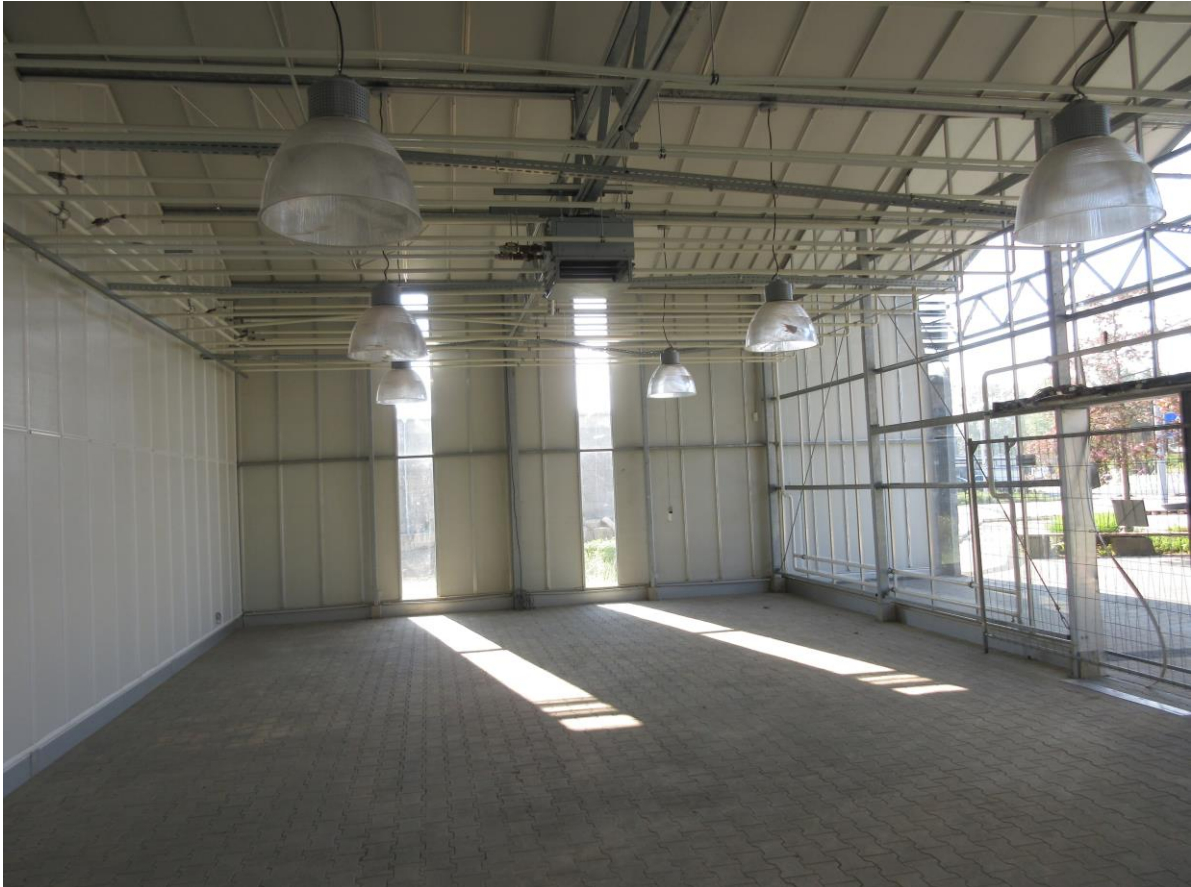
Caritas Werkstätten Sinzig: Verkaufsraum des Gewächshauses im Zustand April 2022
