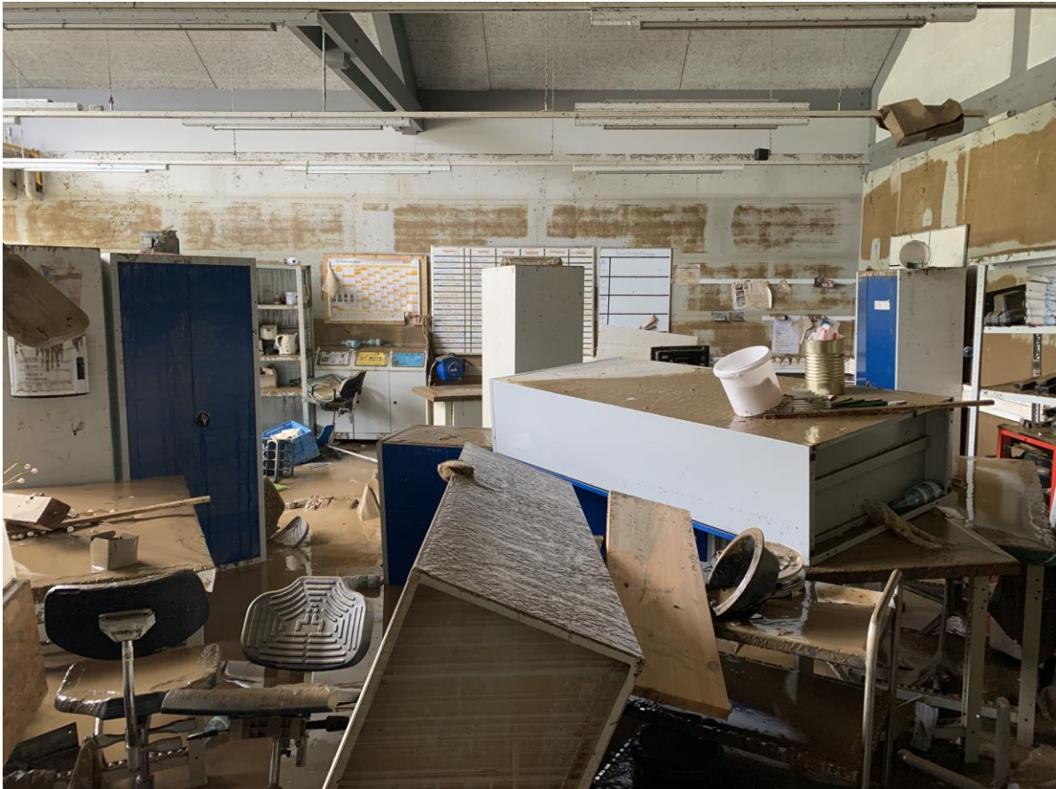
Räumlichkeiten der Haustechnik nach der Flut (Juli 2021)
