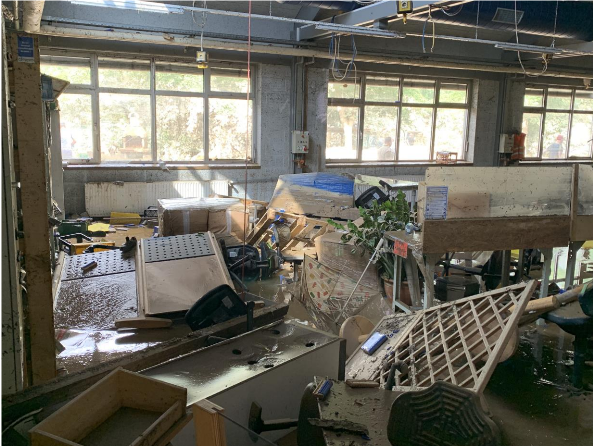
Arbeitsbereich Montage nach der Flut (Juli 2021)
